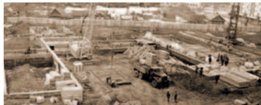
01.05.1974 г. Строительство школы № 20
