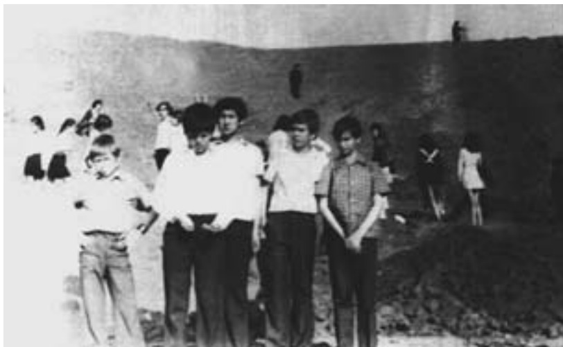
Юные свидетели перекрытия Камы
