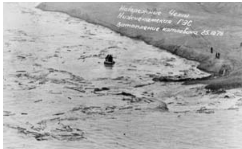
Затопление котлована. В центре тонущая машина отряда БКД. Снимок публикуется впервые
