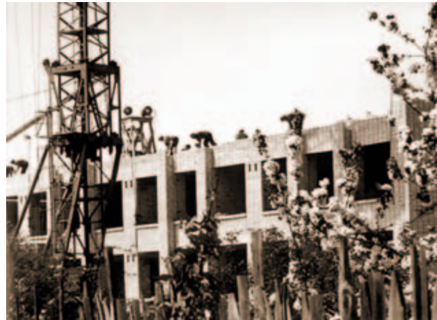
1974 г. Строительство школы № 20
